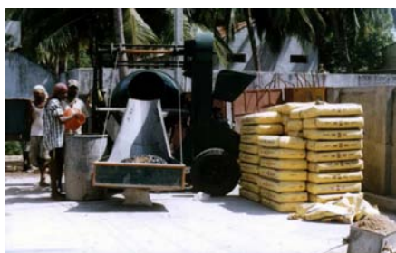
Les travaux ont commencé rapidement !
